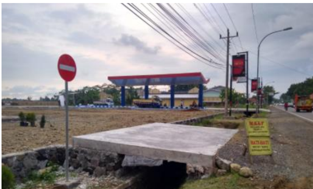
Gambar 3.2 Pembangunan Terminal Kutoarjo (tahap 1)
