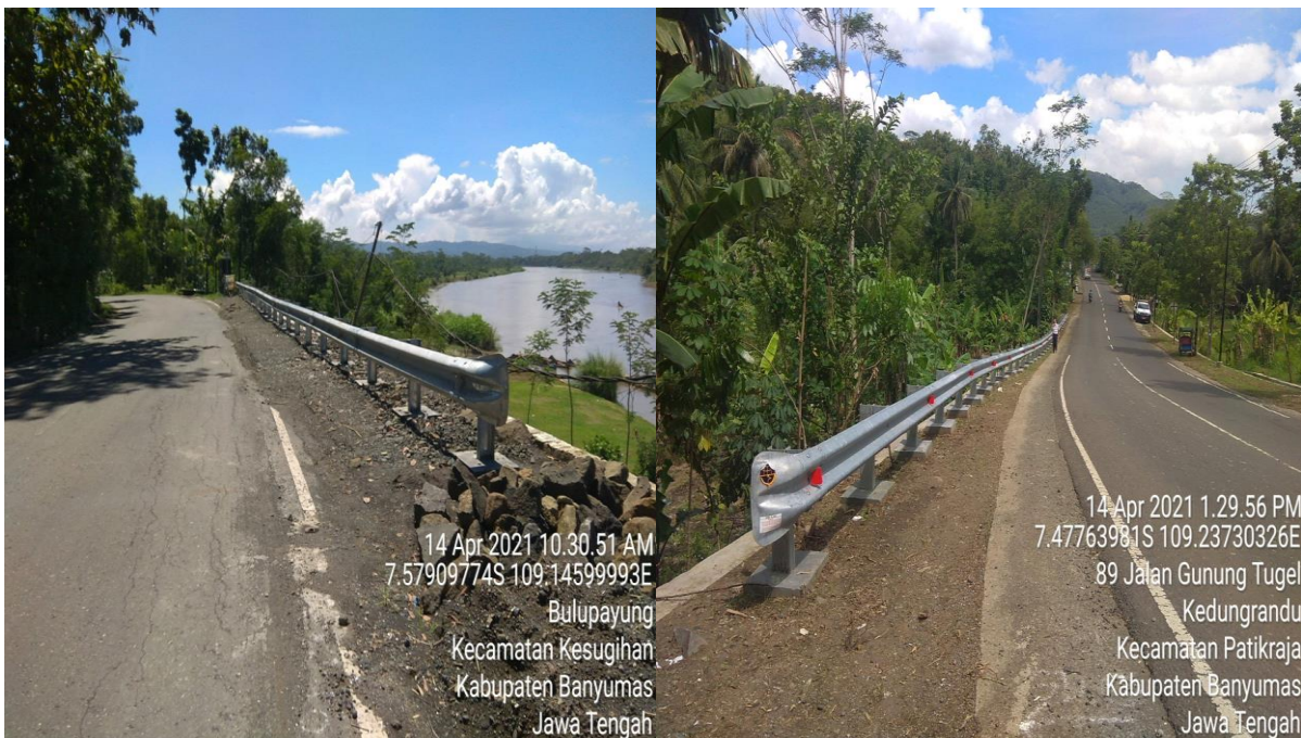
Gambar 3.6 Pemasangan Perlengkapan Jalan (Guard Rail) Kabupaten Banyumas
