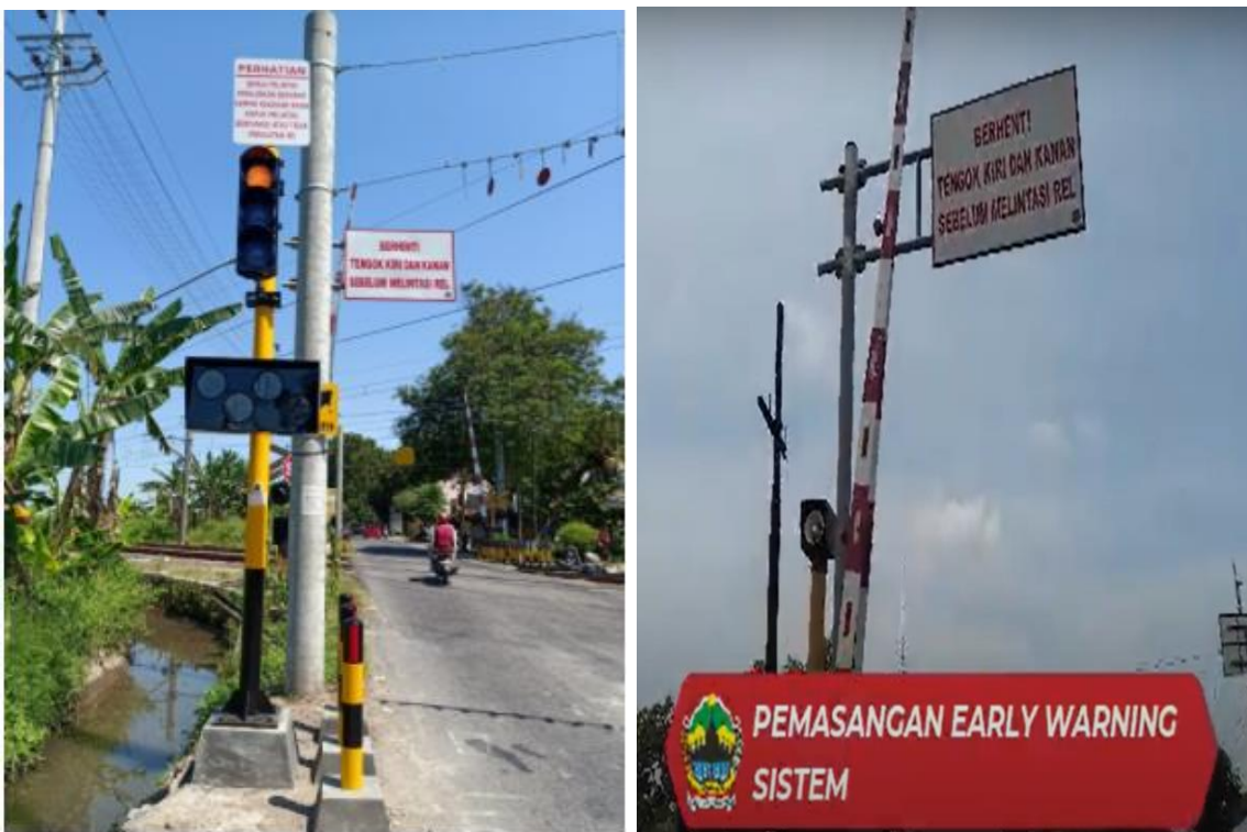
Gambar 3. 7 Fasilitas Keselamatan Jalan Terpasang (EWS) di Perlintasan Sebidang Kereta Api JPL 9 Kabupaten Sukoharjo
