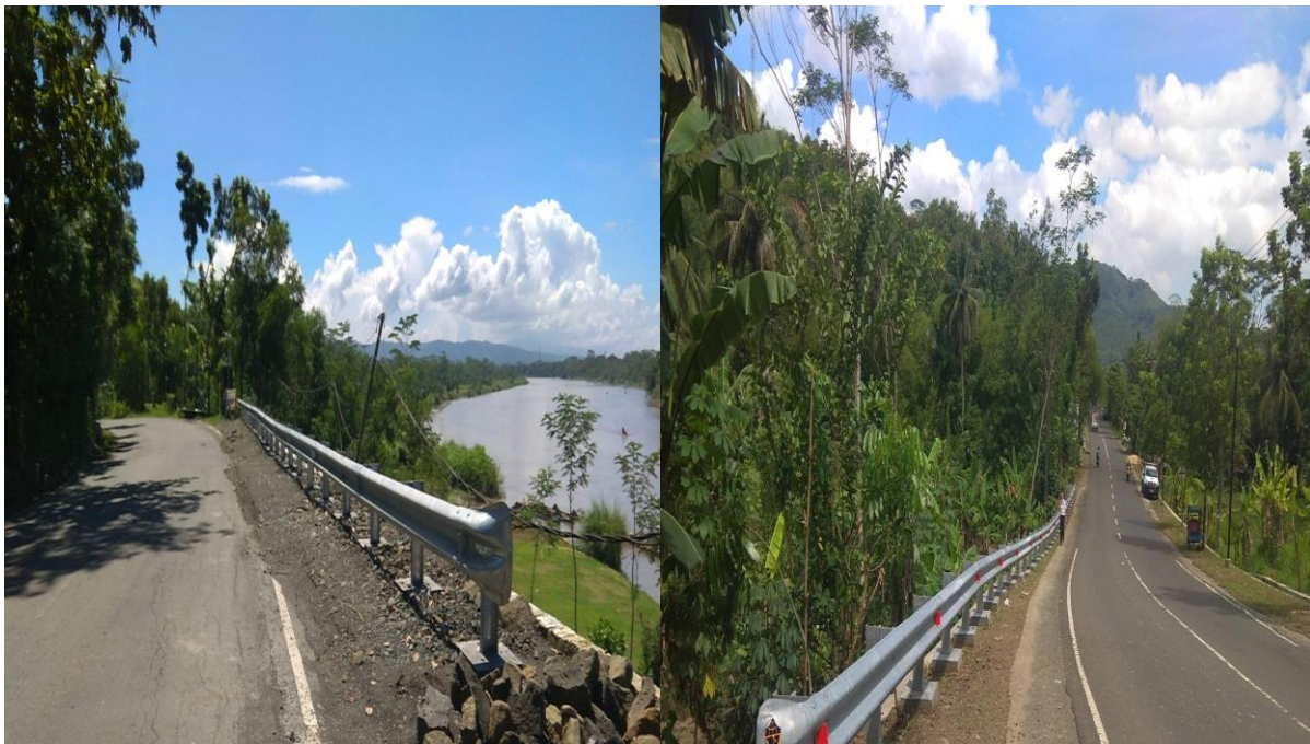
Gambar 3. 4 Pemasangan Perlengkapan Jalan (Guard Rail) Kabupaten Banyumas
