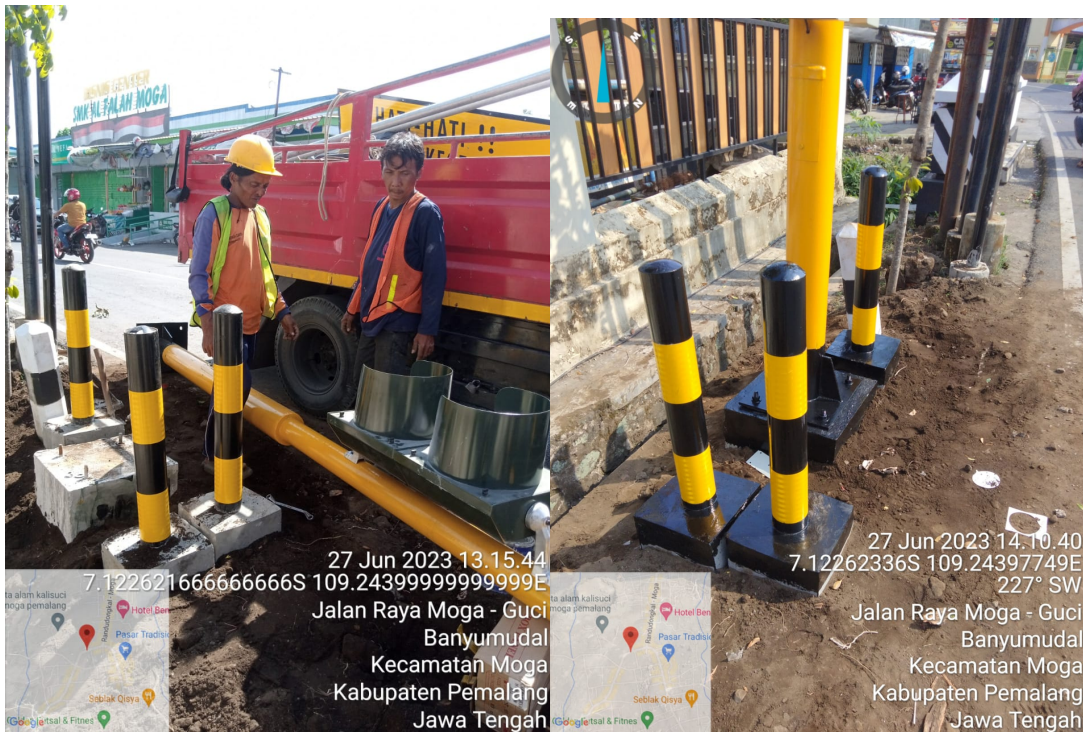
Gambar 3. 5 Pemasangan Perlengkapan Jalan
