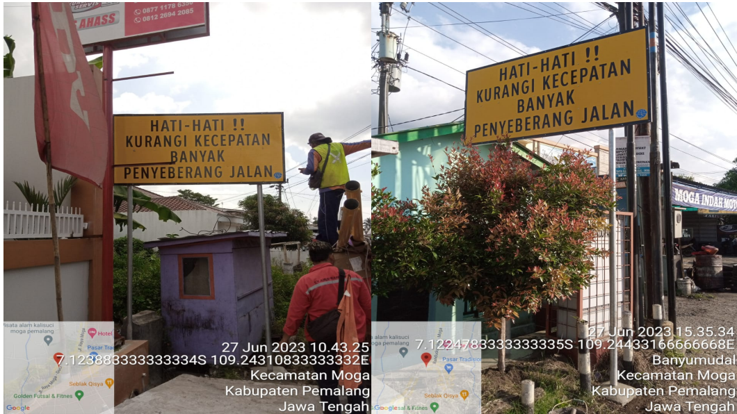
Gambar 3. 4 Rehabilitasi Daerah Rawan Kecelakaan BPSPP Wilayah VI
