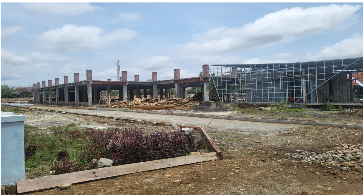
Gambar 3. 3 Pembangunan Terminal Kutoarjo
