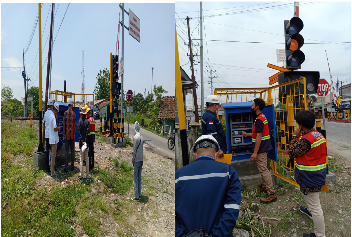
Gambar 3. 8 Fasilitas Keselamatan Jalan Terpasang (EWS)
